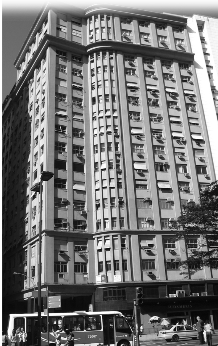
Vista do prédio na esquina da Rio Branco com Santa Luzia - Sede Própria do DAPIBGE
